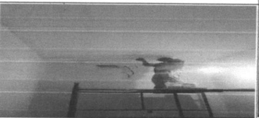
Pintura para interiores, sobre paredes ou tetos, com lixamento, aplicação de 01 demão de líquido selador acrílico, 01 demão de textura acrílica branca e 02 demãos de tinta pva latex convencional para interiores
