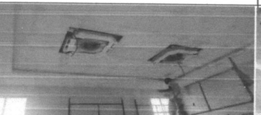
Forro de gesso acartonado
