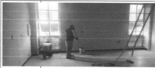
Pintura de acabamento com aplicação de 02 demãos de tinta PVA latex para interiores
