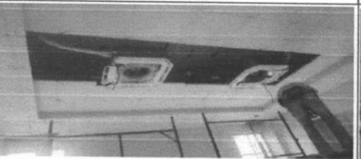
Forro de gesso acartonado
