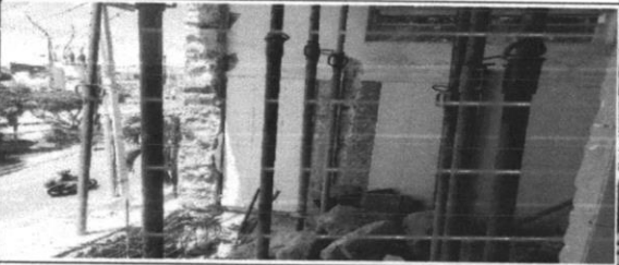
Escoramento metálico para lajes e vigas, c/ escoras tubulares tipo "a" (h=2,08 a 3,20 m), com montagem e desmontagem
