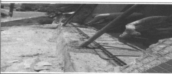
Alvenaria bloco cerâmico vedação, 9x19x24cm, e=19cm, com argamassa
