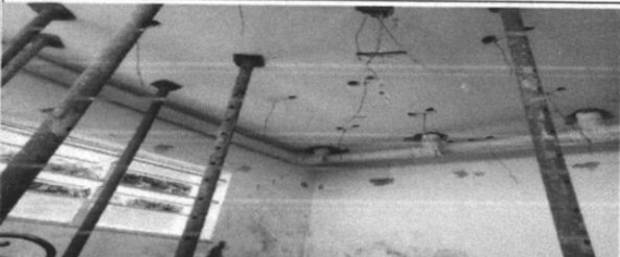
Escoramento metálico para lajes e vigas, c/ escoras tubulares tipo "a" (h=2,08 a 3,20 m), com montagem e desmontagem
