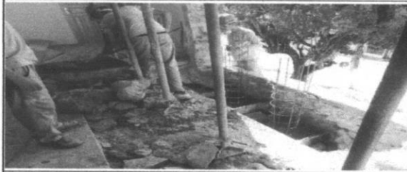
Execução de ferragens na terceira etapa conforme memorial descritivo
