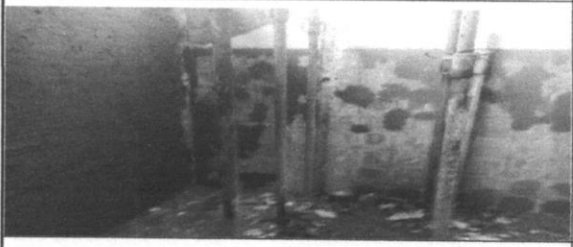
Chapisco em parede com argamassa
