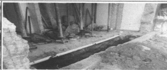
Escavação manual de vala ou cava em material de 2ª categoria, primeira etapa do memorial descritivo
