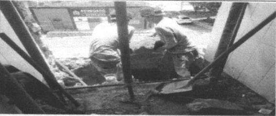
Demolição de alvenaria de tijolo maciço, de forma manual, sem reaproveitamento. Execução segunda etapa conforme memorial descritivo
