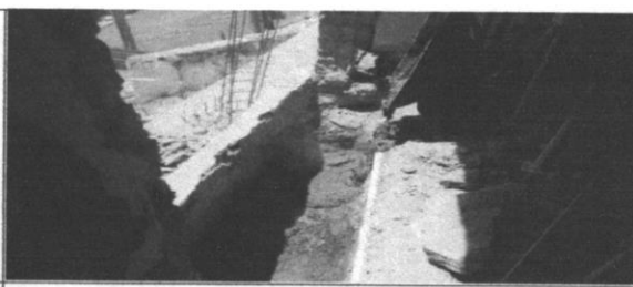
Lastro de concreto magro, aplicado em pisos, lajes sobre solo ou radiers
