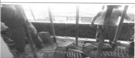
Alvenaria bloco cerâmico vedação, 9x19x24cm, e=19cm, com argamassa
