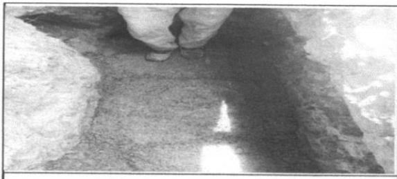
Lastro de concreto magro, aplicado em pisos, lajes sobre solo ou radiers
