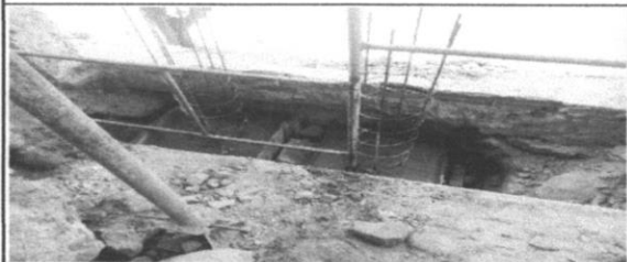
Lançamento de Concreto Armado fck=30,0 MPa na terceira etapa do memorial descritivo
