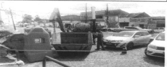
Coleta e carga manuais de entulho
