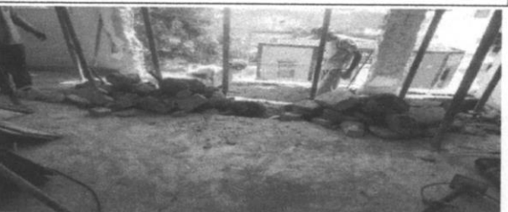
Demolição de alvenaria de tijolo maciço, de forma manual, sem reaproveitamento. Execução terceira etapa conforme memorial descritivo
