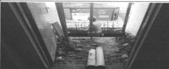
Demolição de piso de alta resistência na Segunda etapa do memoria descritivo
