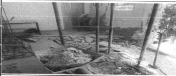
Demolição de piso de alta resistência na Segunda etapa do memoria descritivo
