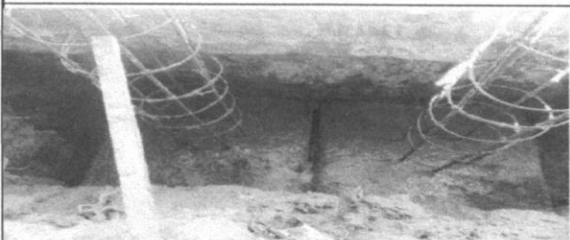
Lançamento de Concreto Armado fck=30,0 MPa na segunda etapa do memorial descritivo
