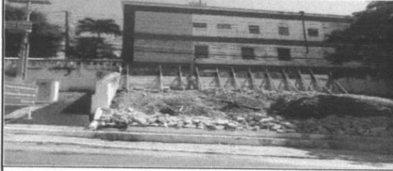
Demolição de alvenaria de tijolo maciço, de forma manual, sem reaproveitamento. Primeira Etapa conforme memorial descritivo.
