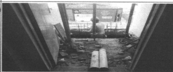
Escavação manual de vala ou cava em material de 2ª categoria, segunda etapa do memorial descritivo
