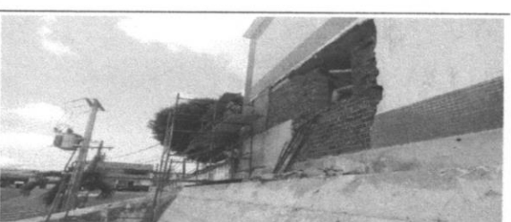
Alvenaria bloco cerâmico vedação, 9x19x24cm, e=19cm, com argamassa
