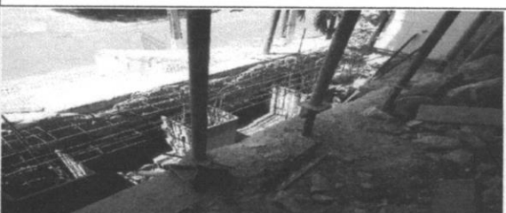
Execução de ferragens na primeira etapa conforme memorial descritivo
