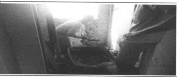
Chapisco em parede com argamassa
