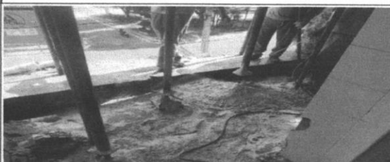
Lançamento de Concreto Armado fck=30,0 MPa na primeira etapa do memorial descritivo
