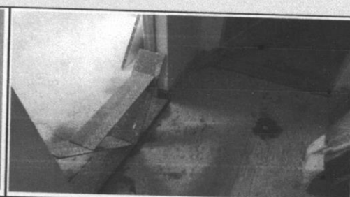
Executado demolição de piso cerâmico
