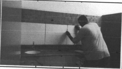
Execução de Pastilha cerâmica esmaltada, 5 x 5 cm Wc Masculino
