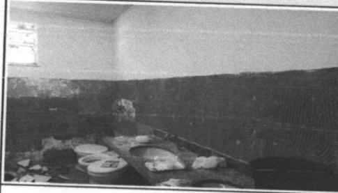
Demolição de revestimento cerâmico, de forma manual, sem reaproveitamento. af_09/2024
