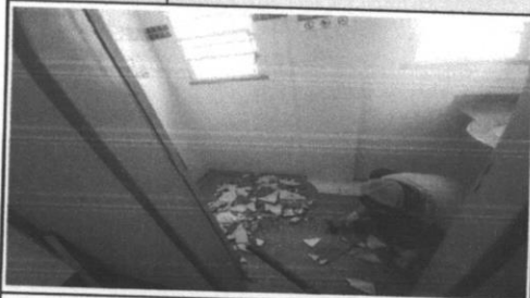
Demolição de revestimento cerâmico, de forma manual, sem reaproveitamento. af_09/2023
