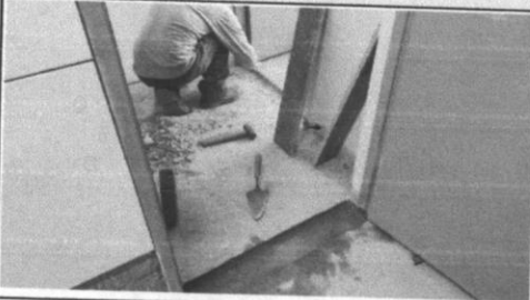
Executado demolição de piso cerâmico
