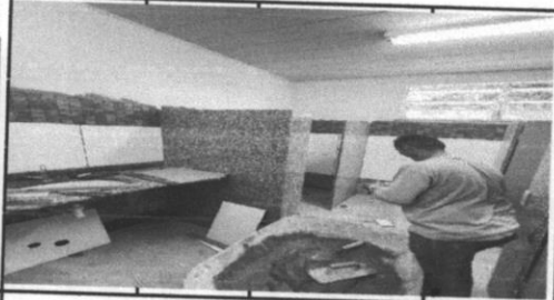
Execução de Pastilha cerâmica esmaltada, 5 x 5 cm
