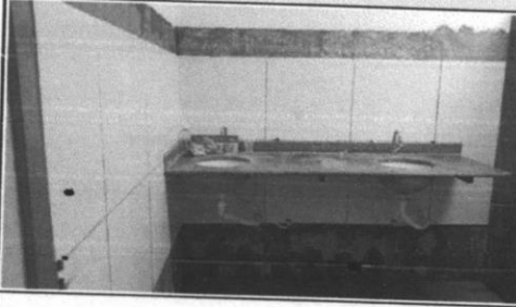
Execução de Pastilha cerâmica esmaltada, 5 x 5 cm Wc Masculino
