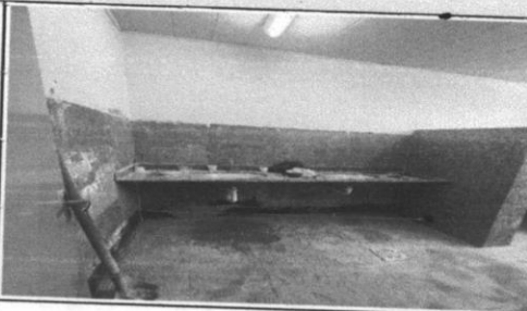
Demolição de revestimento cerâmico, de forma manual, sem reaproveitamento. af_09/2023. WC FEMININO
