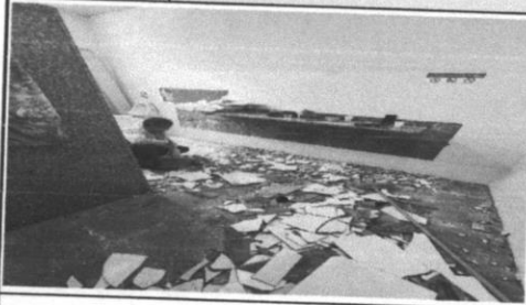
Demolição de revestimento cerâmico, de forma manual, sem reaproveitamento. af_09/2023
