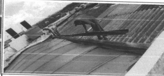
Remoção de calha de zinco
