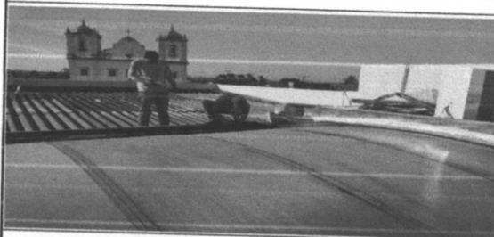
Remoção de calha de zinco
