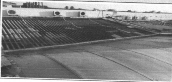
Impermeabilização c/ manta asfáltica aluminizada 3mm
