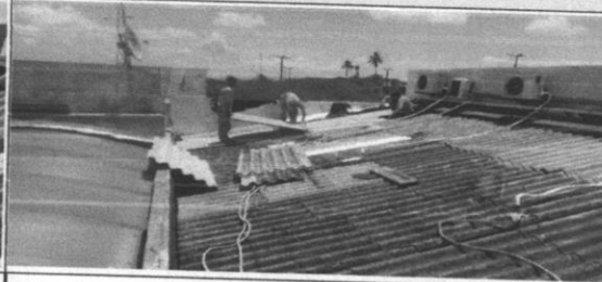
Remoção e reassentamento de telha ondulada de fibro-cimento 4, 6, ou 8mm
