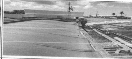
Remoção de calha de zinco
