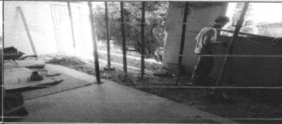
Demolição de alvenaria de tijolo maciço, de forma manual, sem reaproveitamento. Quarta Etapa conforme memorial descritivo.
