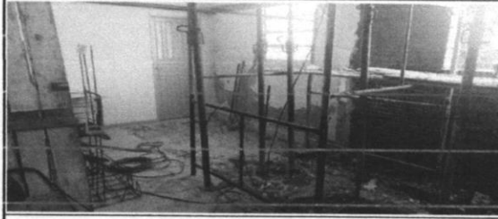
Demolição de alvenaria de tijolo maciço, de forma manual, sem reaproveitamento. Quarta Etapa conforme memorial descritivo.
