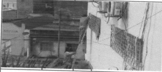
Pintura de proteção sobre superfícies metálicas com aplicação de 01 demão de tinta anti-corrosiva zarcão - R2
