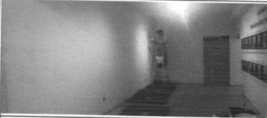
Pintura de acabamento com aplicação de 02 demãos de tinta PVA latex para interiores - cores convencionais - Rev 03
