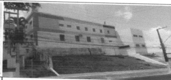
Restauro - Lavagem de paredes com cloro líquido
