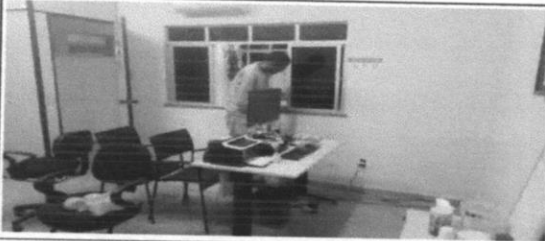
Pintura de acabamento com aplicação de 02 demãos de tinta PVA latex para interiores - cores convencionais - Rev 03
