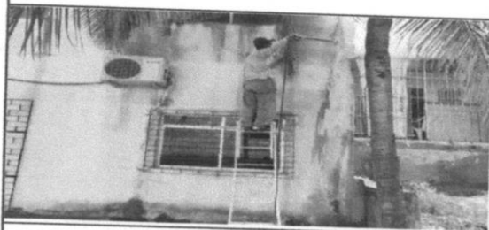
Restauro - Lavagem de paredes com cloro líquido
