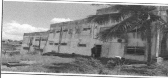
Restauro - Lavagem de paredes com cloro líquido
