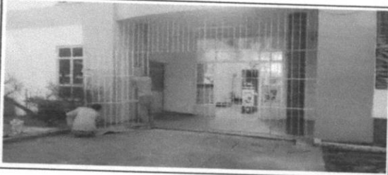
Pintura de proteção sobre superfícies metálicas com zarcão e aplicação de pintura metálica na cro cinza médio
