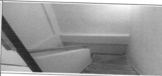
Pintura de acabamento com aplicação de 02 demãos de tinta PVA latex para interiores - cores convencionais - Rev 03
