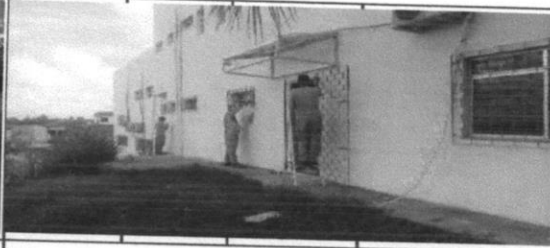
Pintura de proteção sobre superfícies metálicas com zarcão e aplicação de pintura metálica na cro cinza médio
