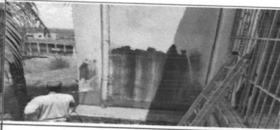
Restauro - Lavagem de paredes com cloro líquido
