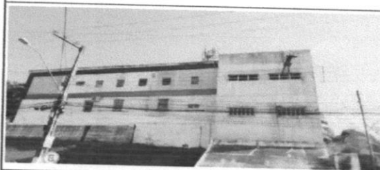
Pintura de acabamento com aplicação de 02 demãos de tinta PVA latex para exteriores
