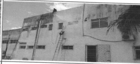
Restauro - Lavagem de paredes com cloro líquido
