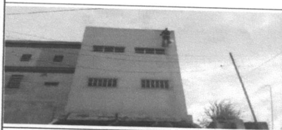
Restauro - Lavagem de paredes com cloro líquido
