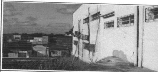
Restauro - Lavagem de paredes com cloro líquido
